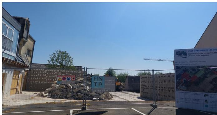
La déconstruction des 637 m2 de bâtiments sur l'espace Anne Leclerc a débuté en février 2025. Elle a commencé par l'ancien centre de tri de La Poste avec la mise en place des cloisons mitoyennes et le curage du centre de tri. Puis les menuiseries amiantées ont été retirées et enfin la déconstruction du centre de tri a pu être finalisée. Concernant l'ancienne étable elle a été démolie au cours du mois de mars. Les matériaux ont été triés puis mis en benne.
